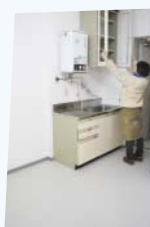
給湯設備のある休憩室。棚はつくり付け。
